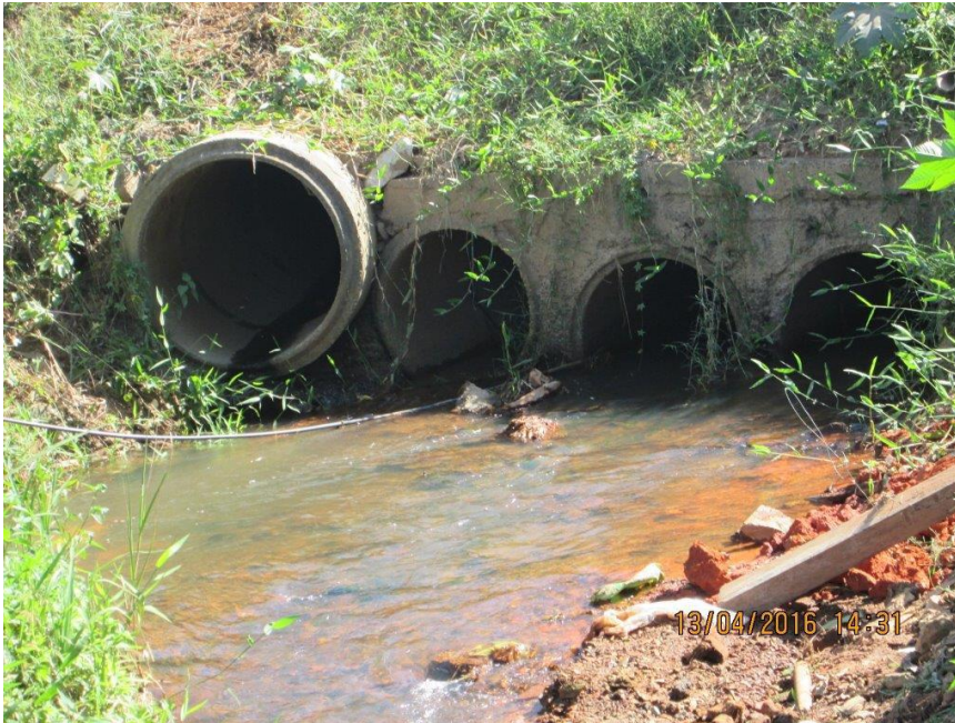
Demolição de contenção em concreto
