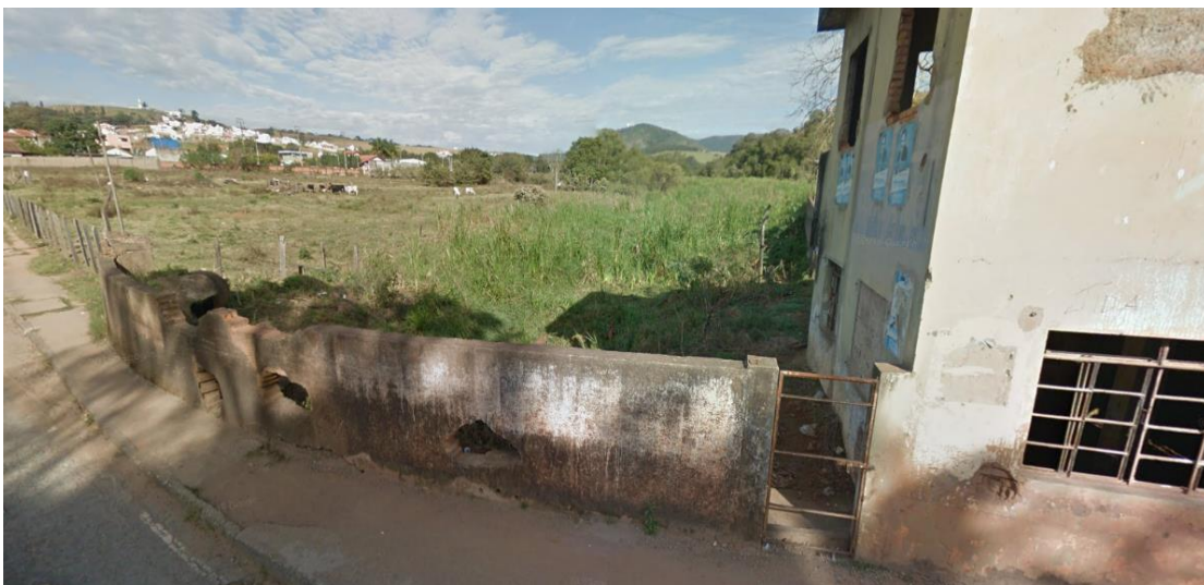
Demolição de alvenaria existente
